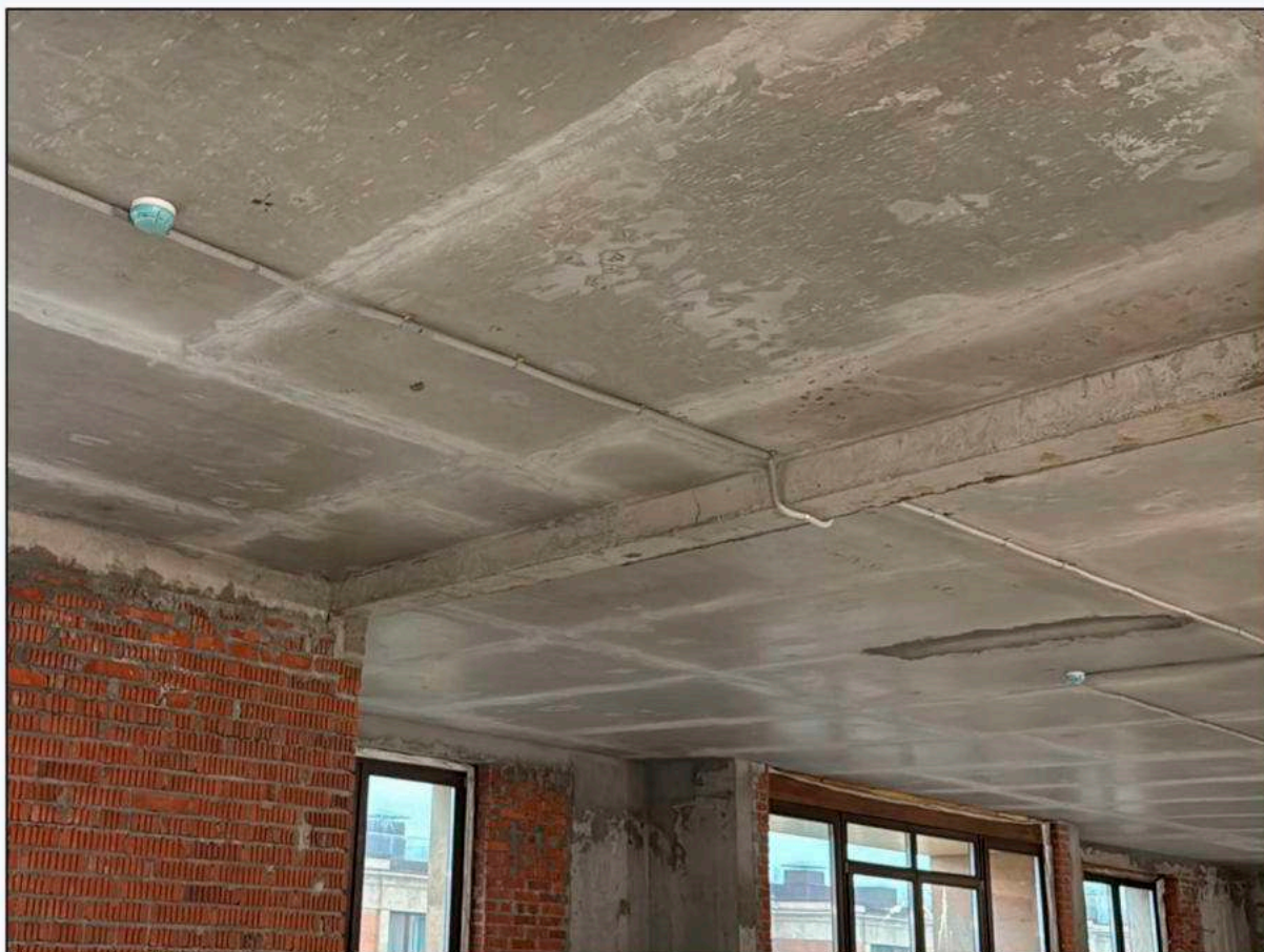
Фото 27. Общий вид ребра монолитного покрытия Объекта обследования.
