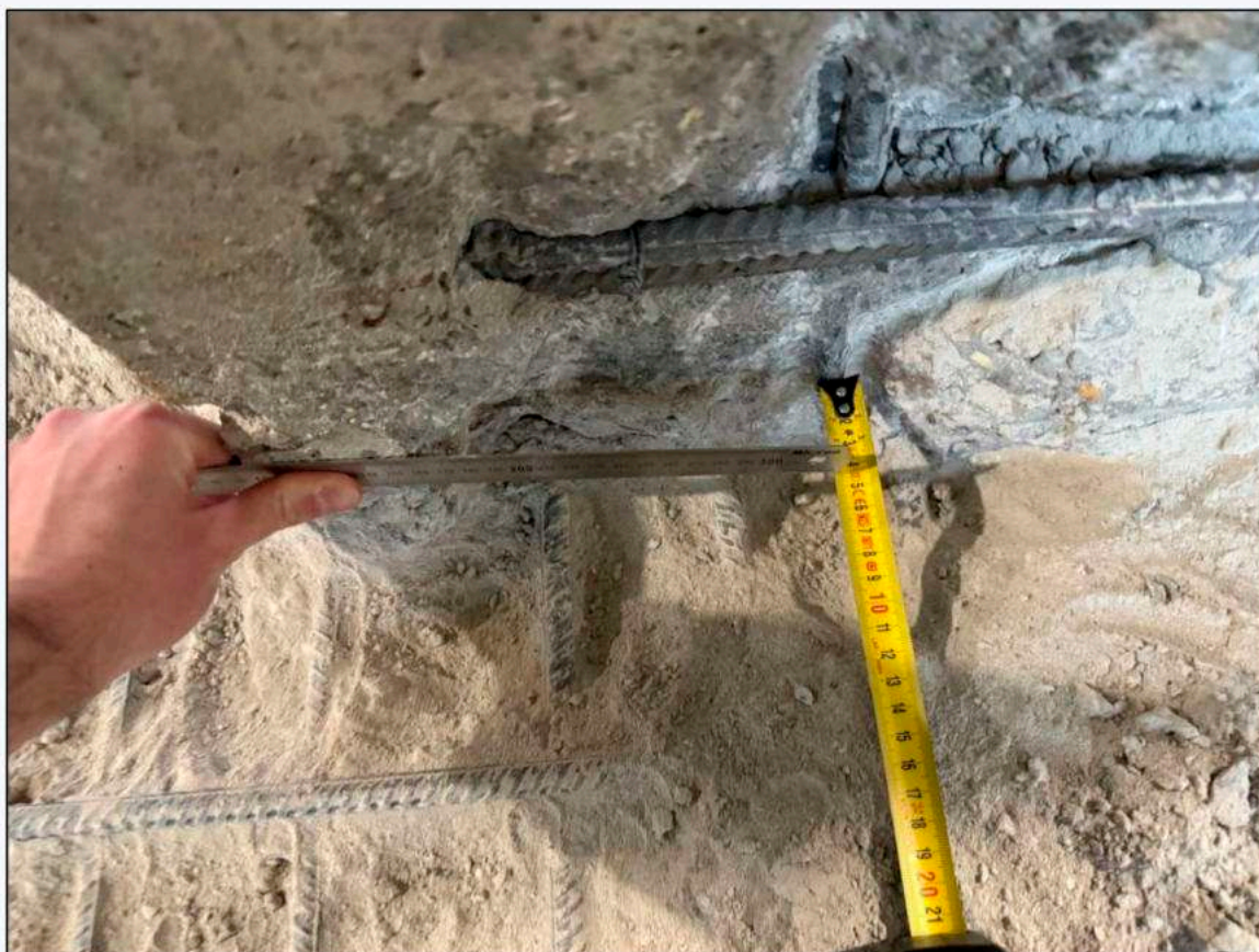
Фото 30. Определение геометрических параметров защитного слоя бетона центральной стены Объекта.
