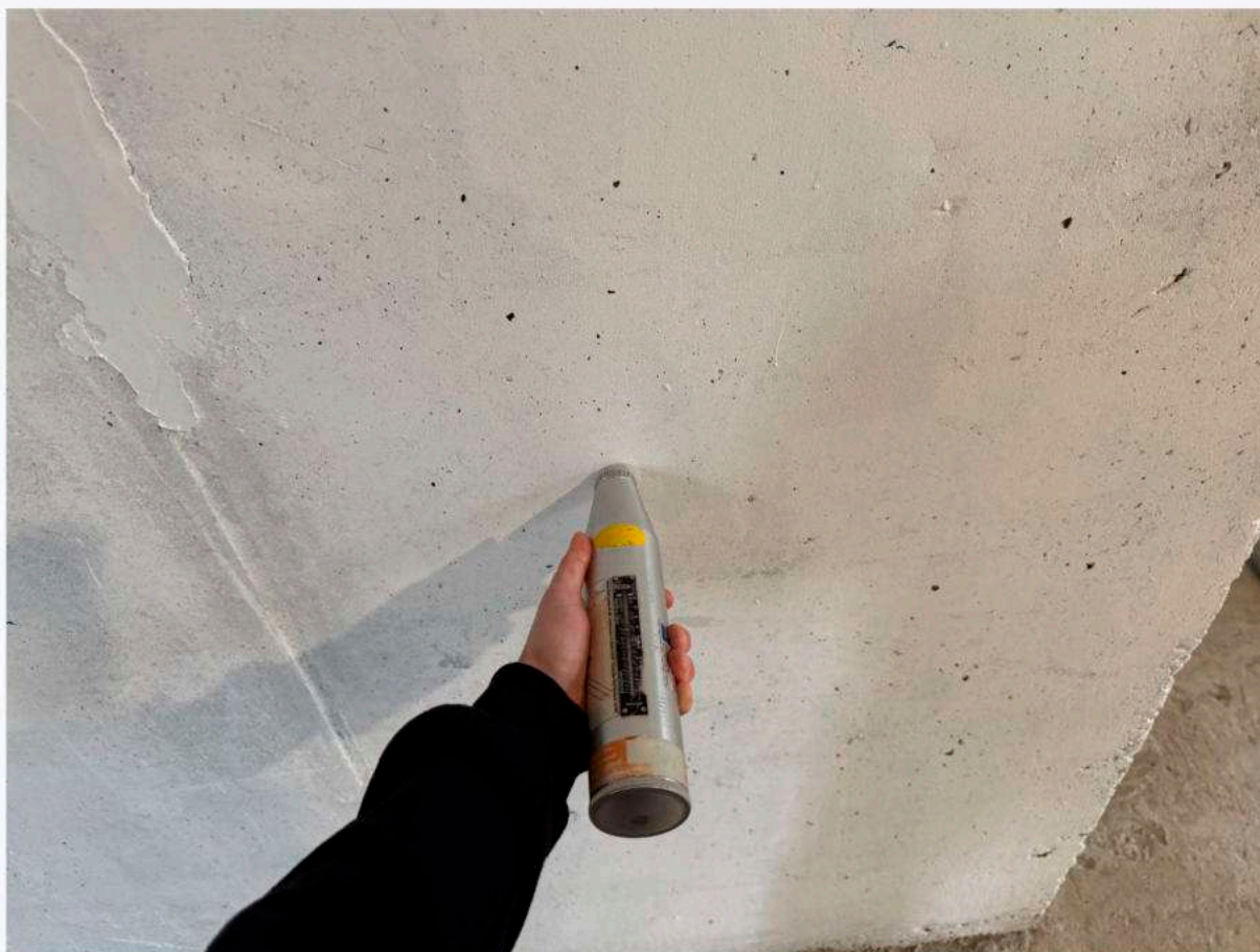
Фото 34. Определение прочностных параметров бетона ж/б стены Объекта.
