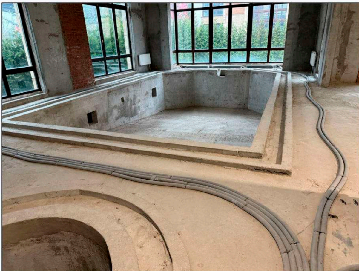
Фото 20. Общий вид чаши бассейна Объекта обследования.
