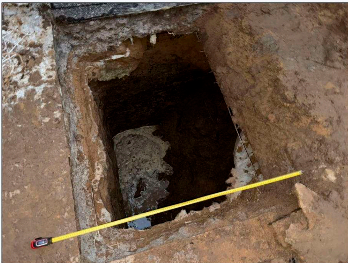
Фото 42. Определение геометрических параметров шурфа Объекта обследования.
