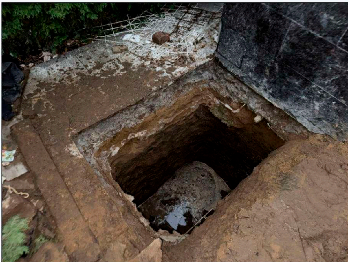
Фото 41. Общий вид шурфа Объекта обследования.
