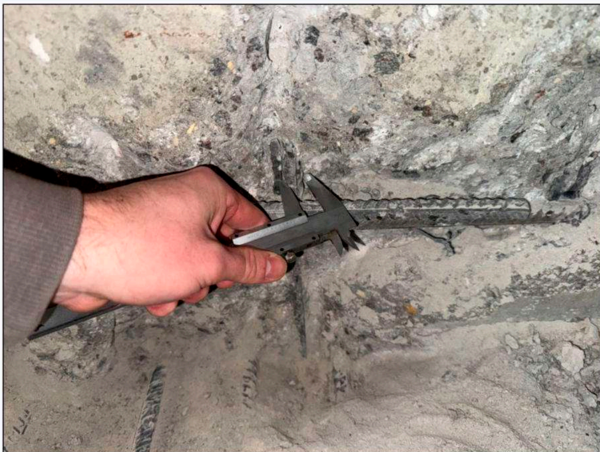
Фото 29. Определение параметров армирования центральной стены Объекта.
