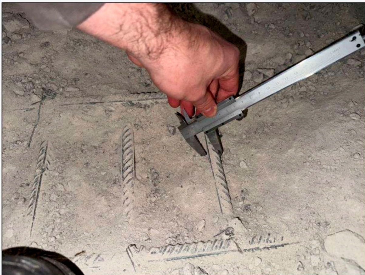
Фото 33. Определение параметров армирования перекрытия 1 этажа Объекта.
