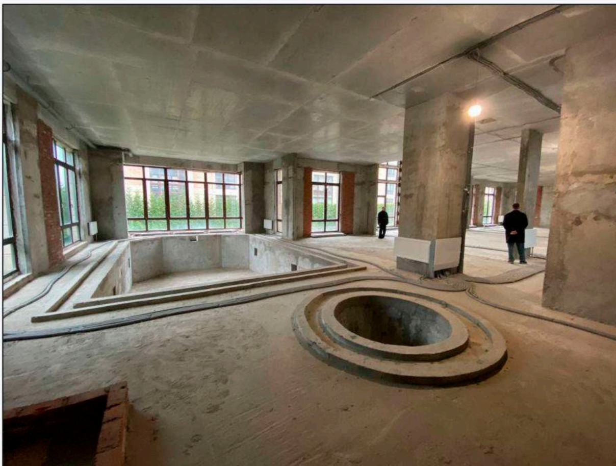
Фото 5. Общий вид помещения в уровне первого этажа Объекта обследования.
