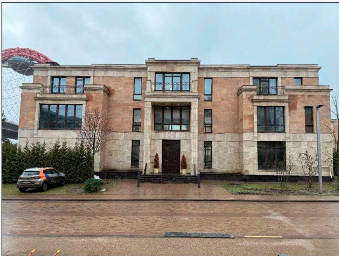
Фото 1. Общий вид объекта обследования с восточной стороны.
