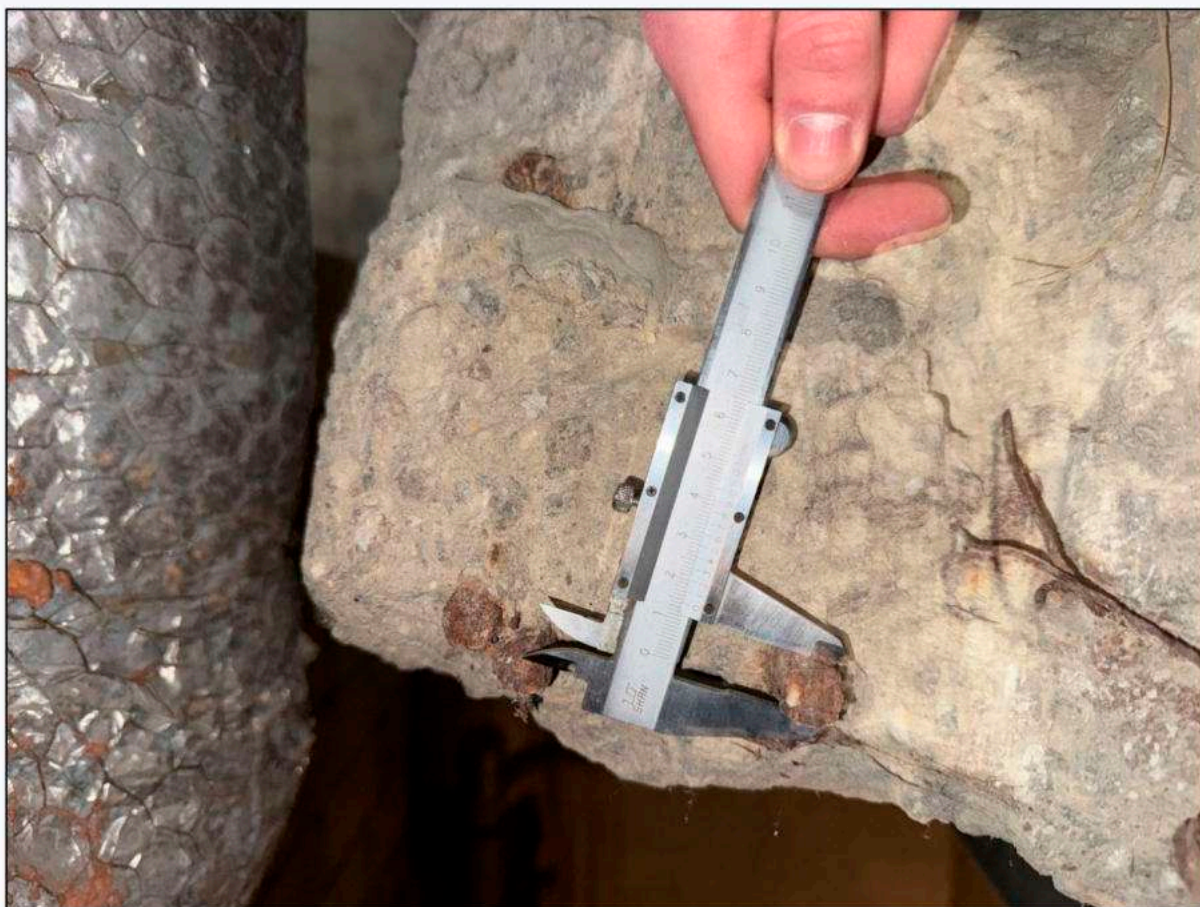
Фото 38. Определение параметров армирования перекрытия 1 этажа Объекта.
