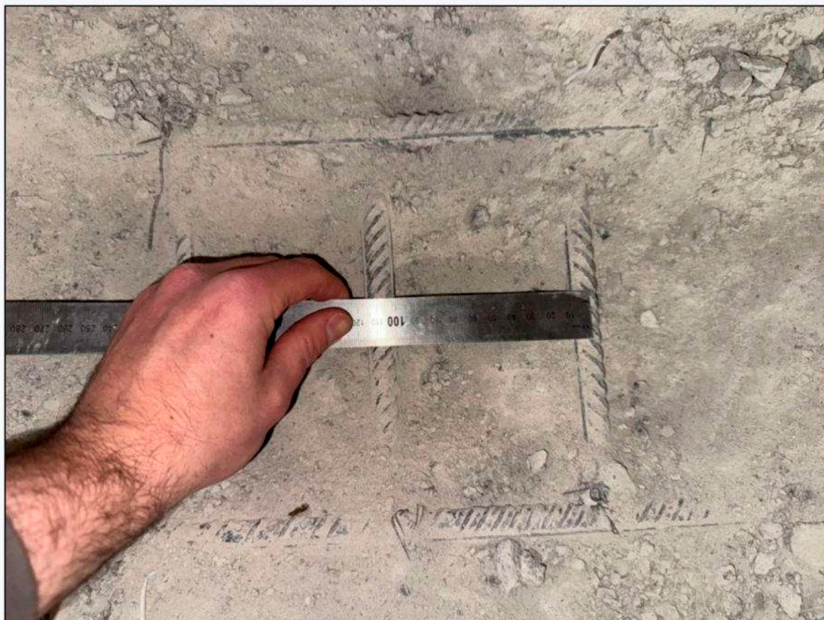
Фото 32. Определение параметров армирования перекрытия 1 этажа Объекта.
