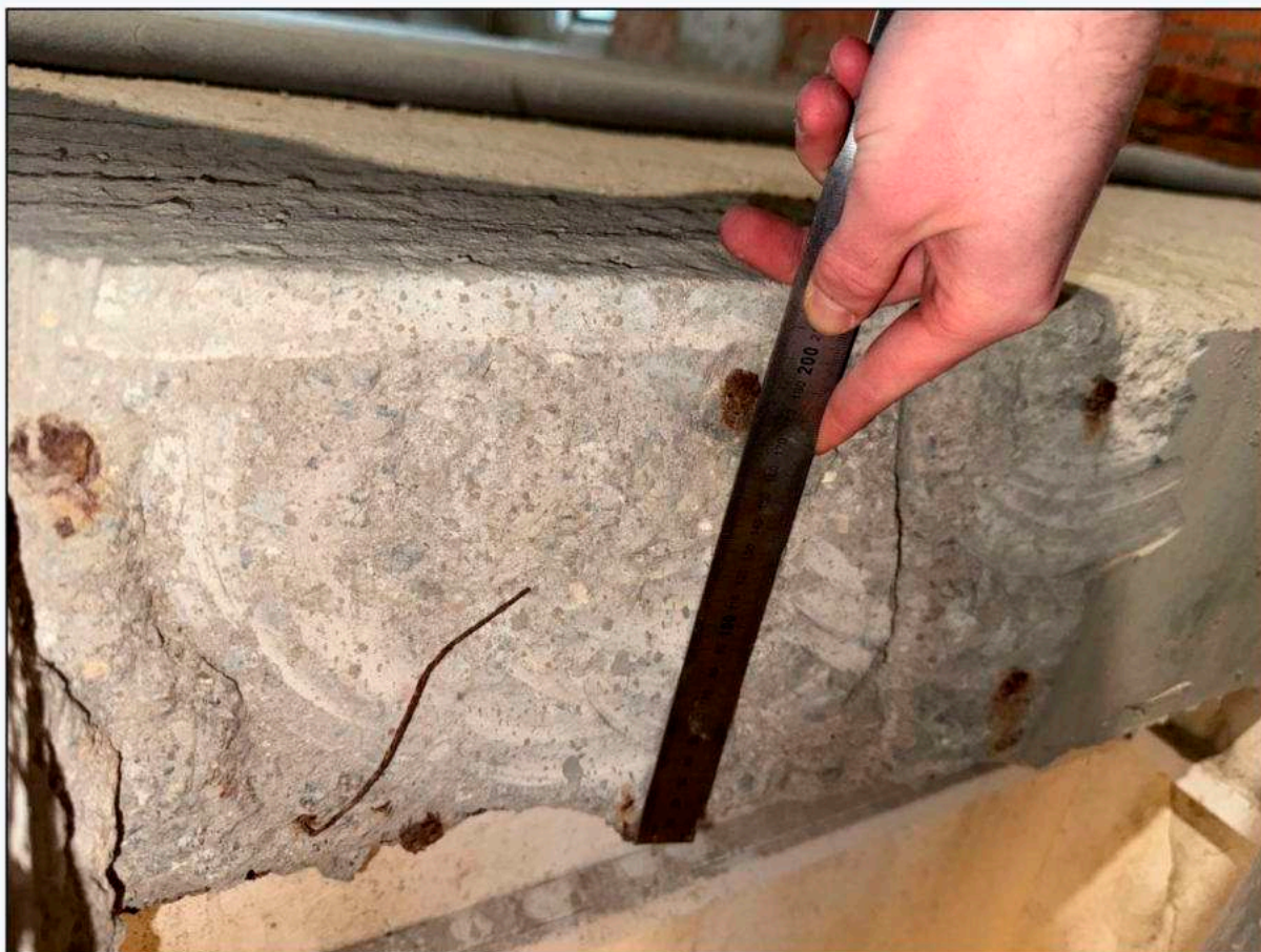
Фото 37. Определение параметров армирования перекрытия 1 этажа Объекта.
