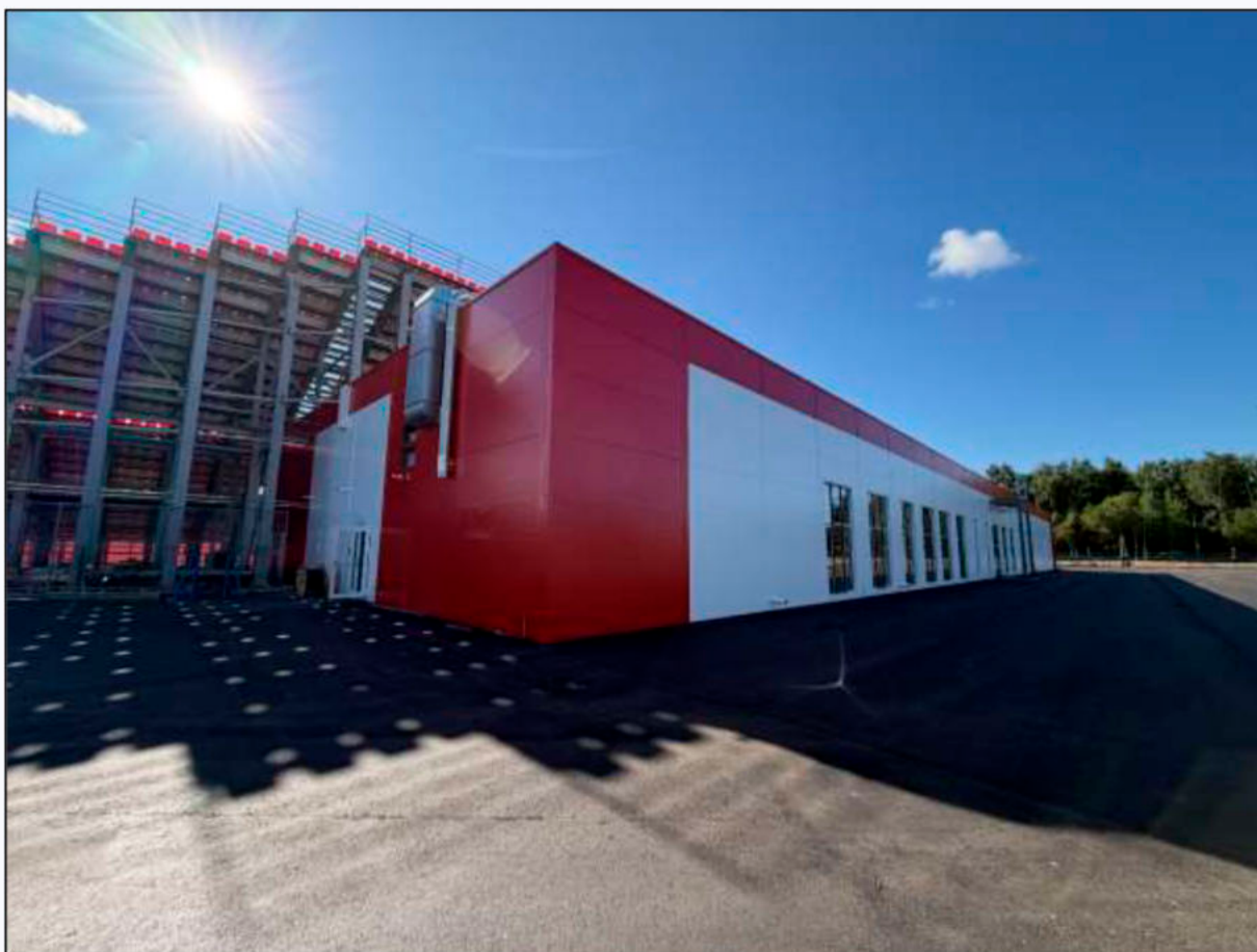
Фото 4. Общий вид фасада здания АБК.
