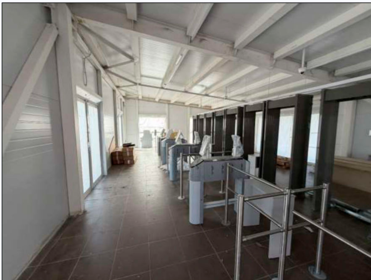
Фото 13. Общий вид внутри здания КПП.
