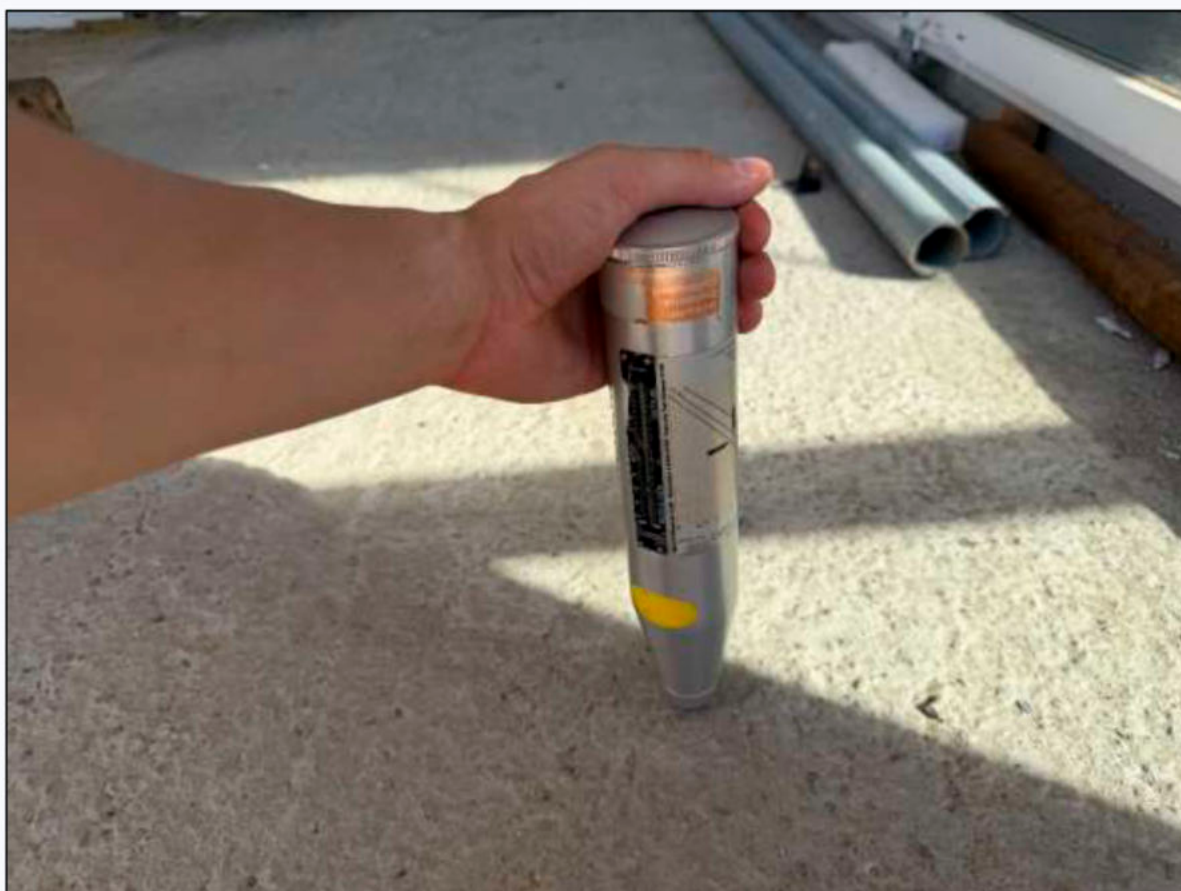
Фото 14. Общий вид определения прочности бетона фундаментной плиты КПП методом упругого отскока.
