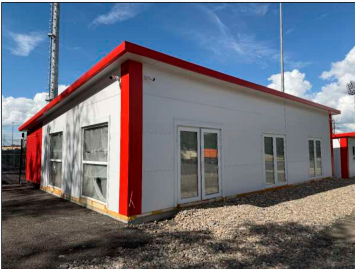
Фото 12. Общий вид фасадов здания КПП.
