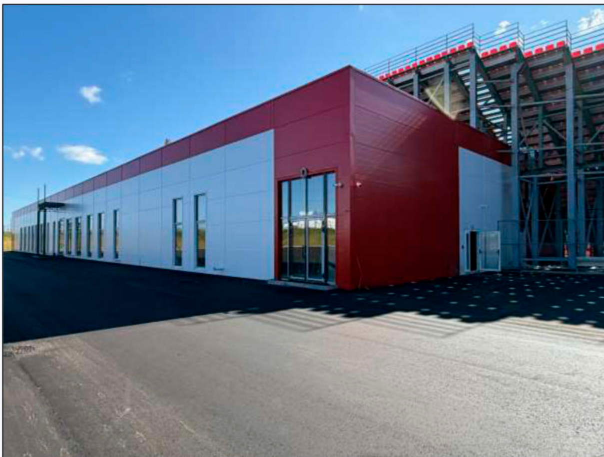
Фото 3. Общий вид фасада здания АБК.
