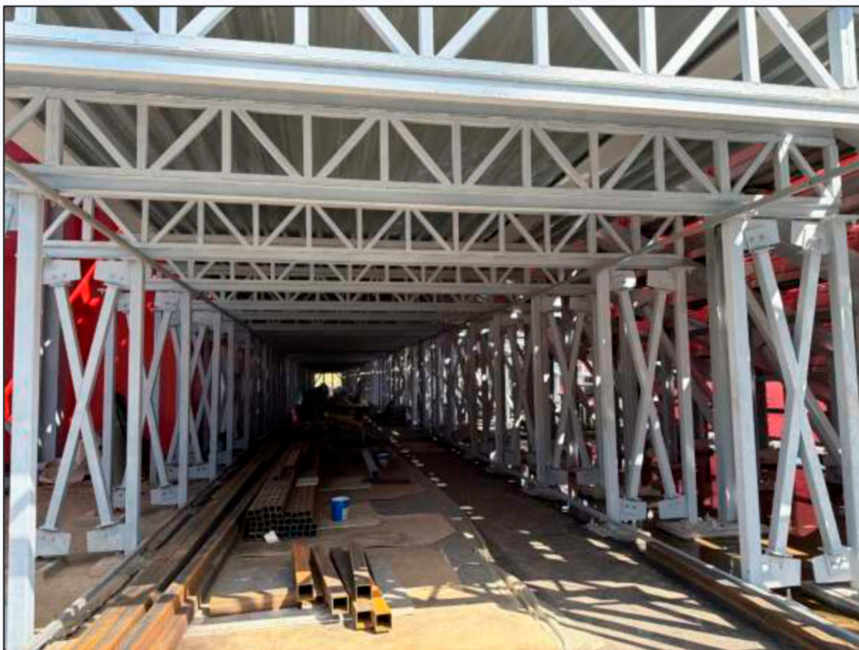
Фото 7. Общий вид конструкций большой трибуны.
