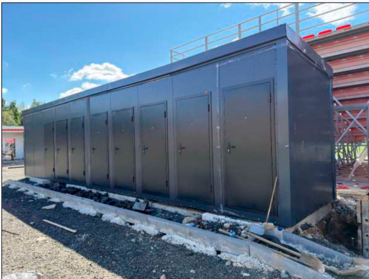
Фото 11. Общий вид фасадов здания санузлов.
