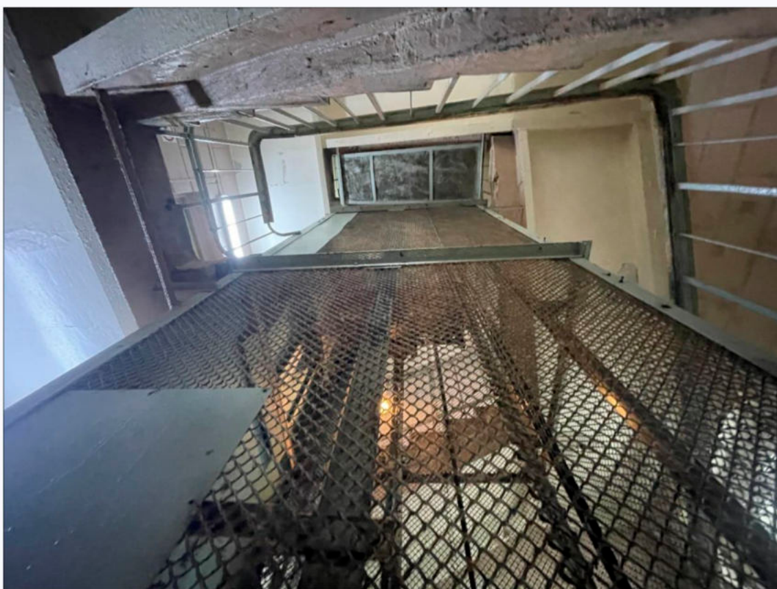
Фото 2. Общий вид Объекта обследования.
