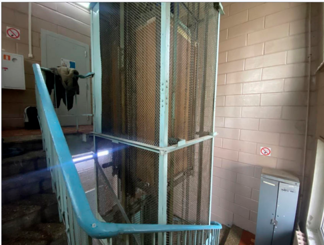
Фото 1. Общий вид Объекта обследования.
