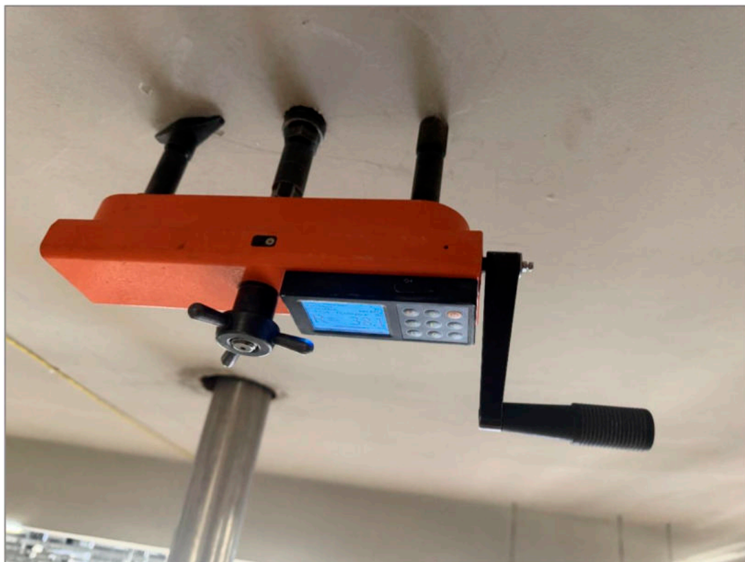
Фото 9. Определение прочности бетона плиты покрытия Объекта обследования методом неразрушающего контроля «отрыв со скалыванием».
