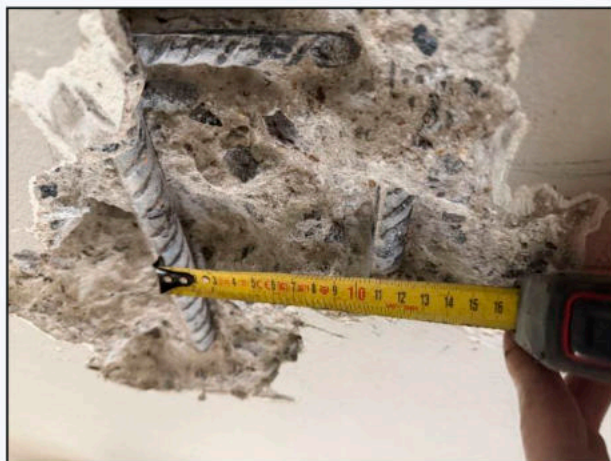
Фото 7. Общий вид вскрытия № 1 плиты покрытия здания в осях «3-4/В» с фиксацией параметров армирования
