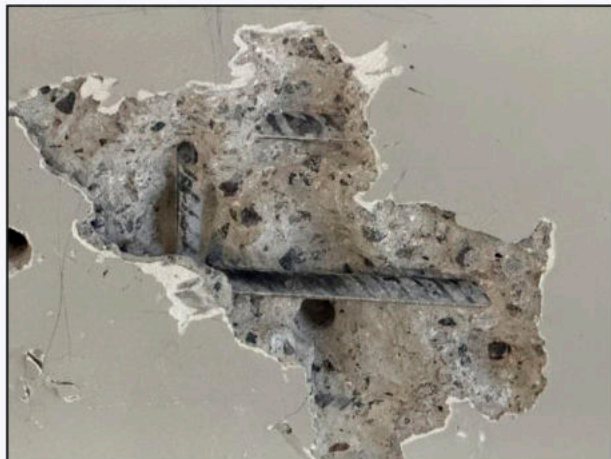
Фото 5. Общий вид вскрытия № 1 плиты покрытия здания в осях «3-4/В»
