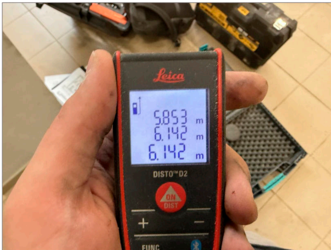
Фото 11. Определение геометрических параметров плиты покрытия.
