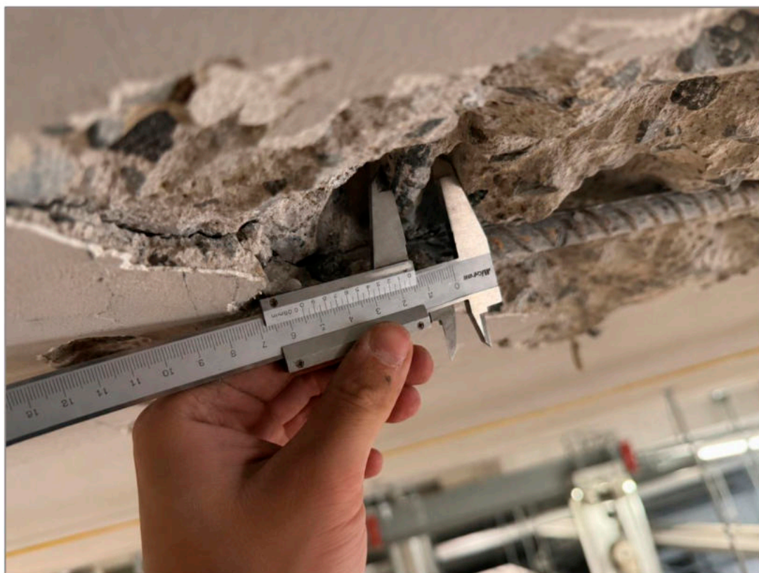
Фото 14. Определение геометрических параметров армирования плиты покрытия Объекта обследования.
