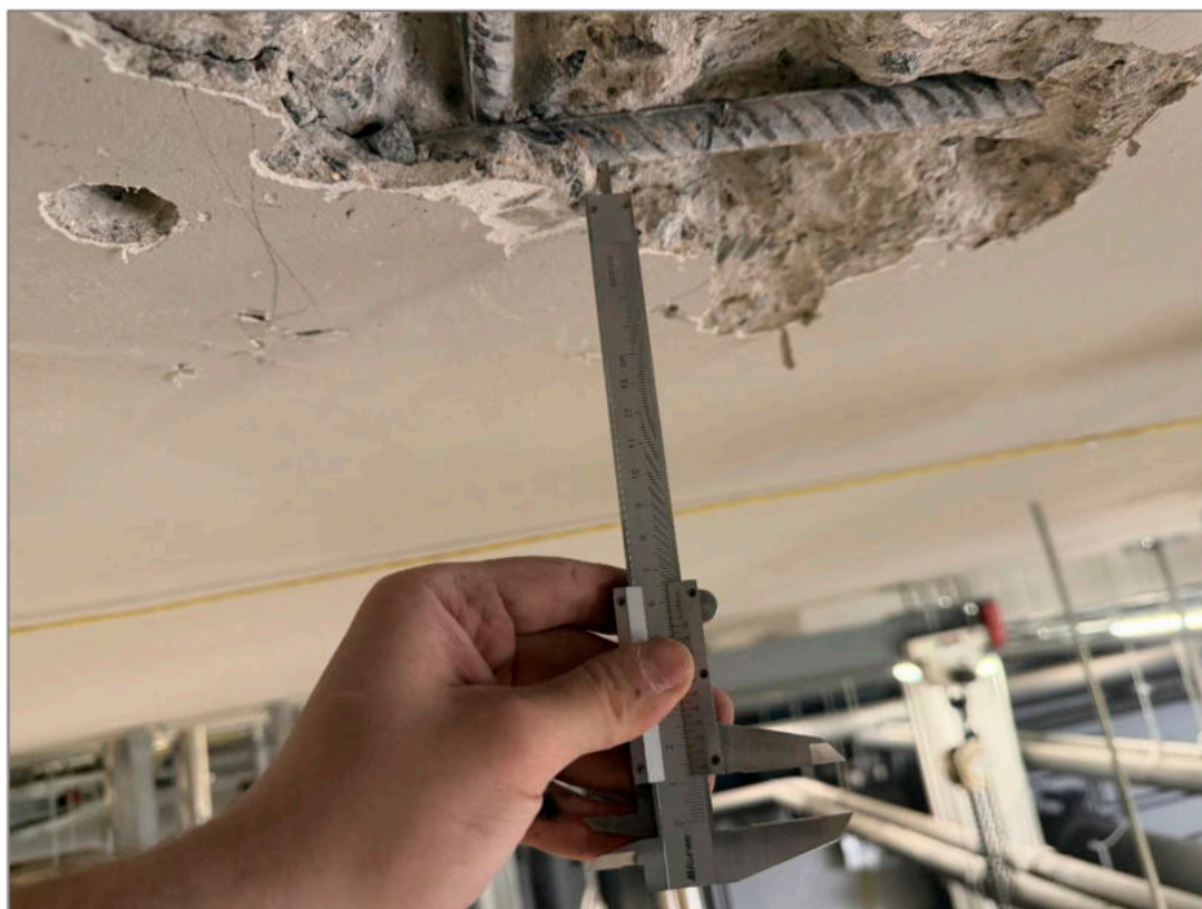
Фото 12. Определение геометрических параметров армирования плиты покрытия Объекта обследования.
