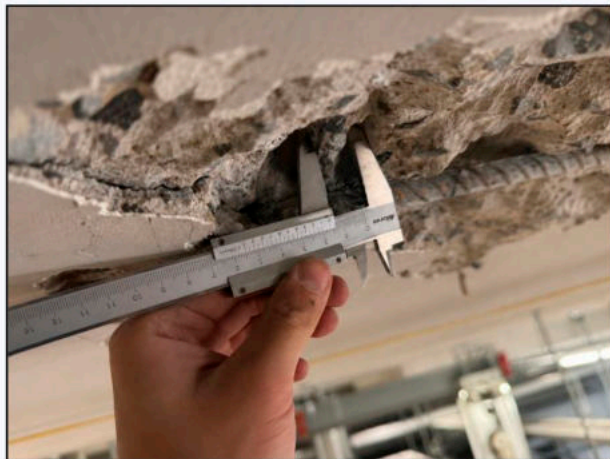
Фото 6. Общий вид вскрытия № 1 плиты покрытия здания в осях «3-4/В» с фиксацией параметров армирования
