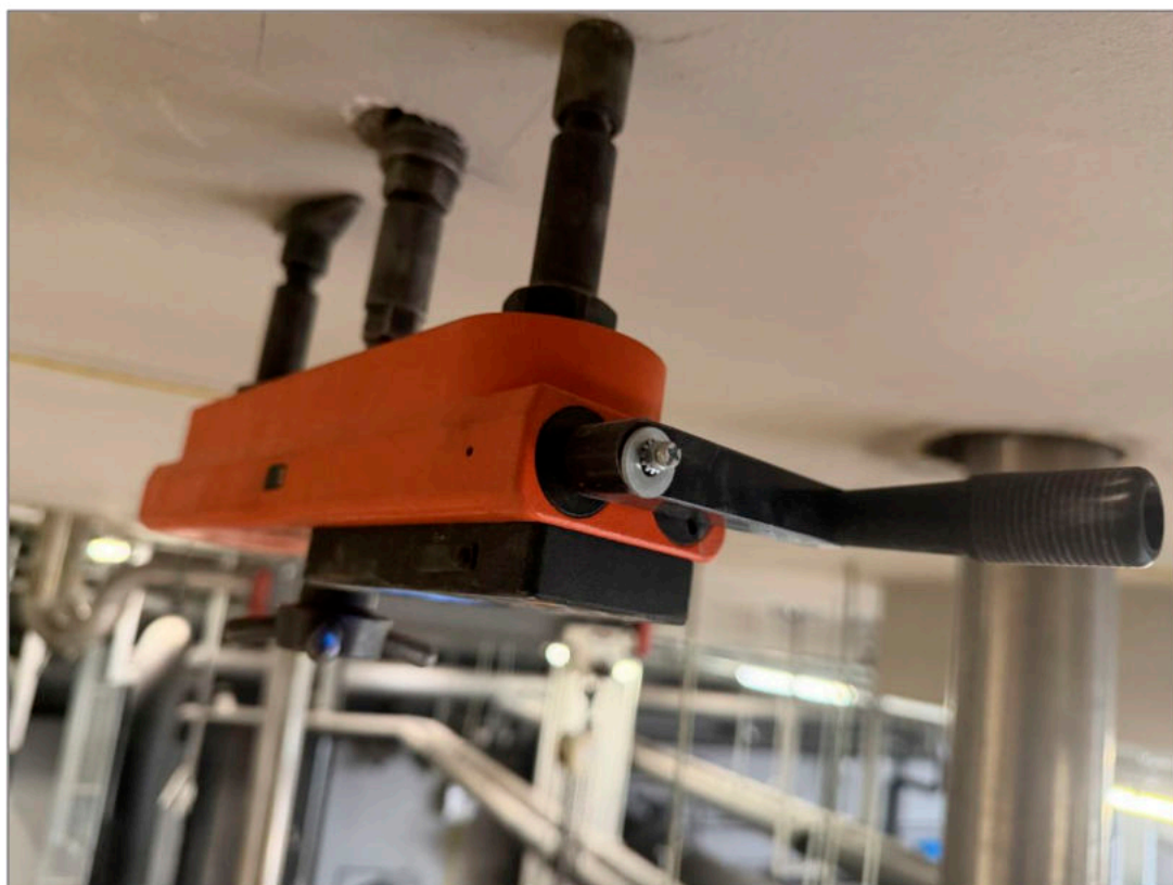
Фото 10. Определение прочности бетона плиты покрытия Объекта обследования методом неразрушающего контроля «отрыв со скалыванием».
