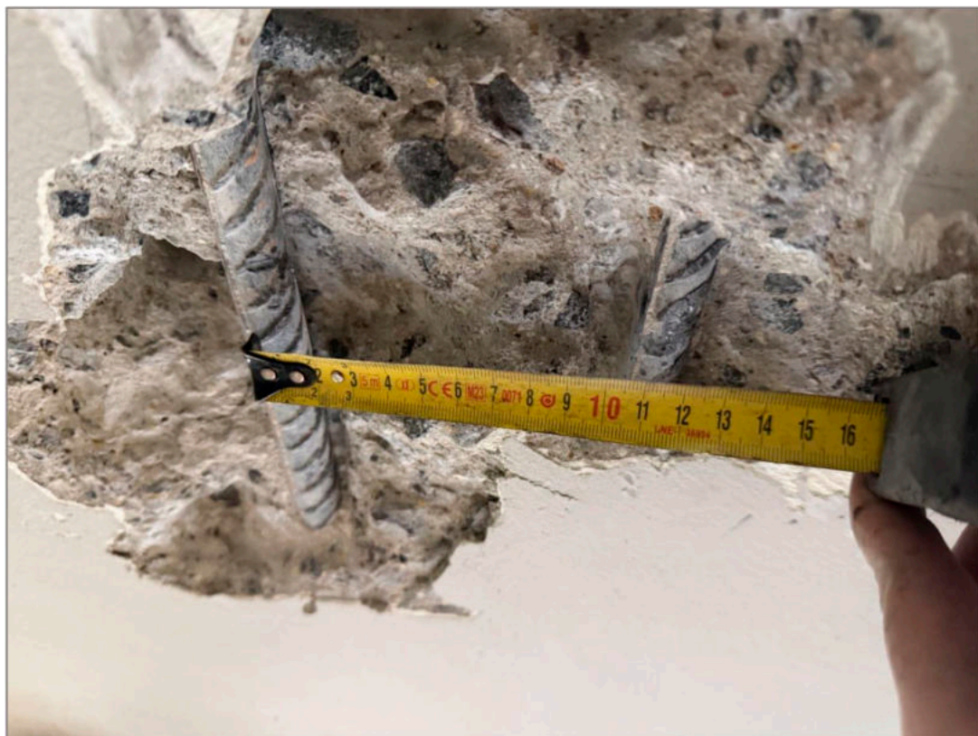
Фото 13. Определение геометрических параметров армирования плиты покрытия Объекта обследования.
