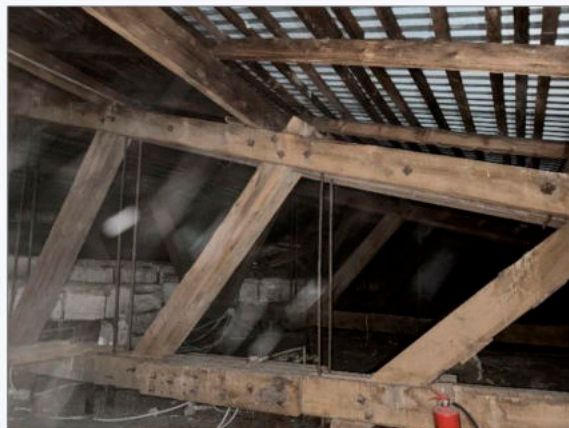
Фото 2. Общий вид стропильной системы
