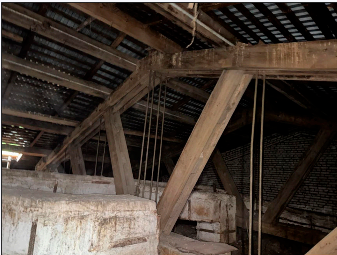
Фото 19. Локальный вид стропильной системы
