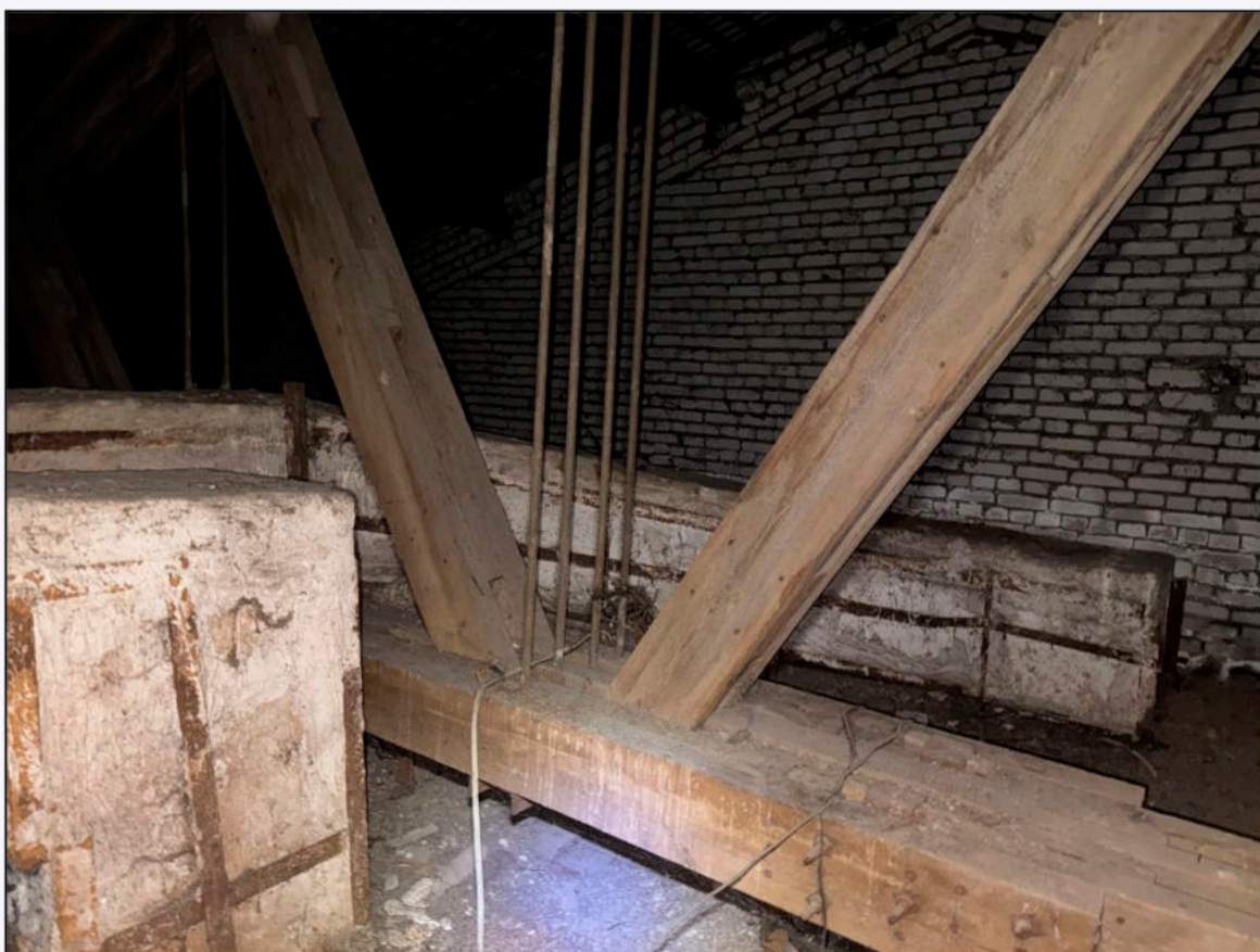
Фото 20. Локальный вид стропильной системы
