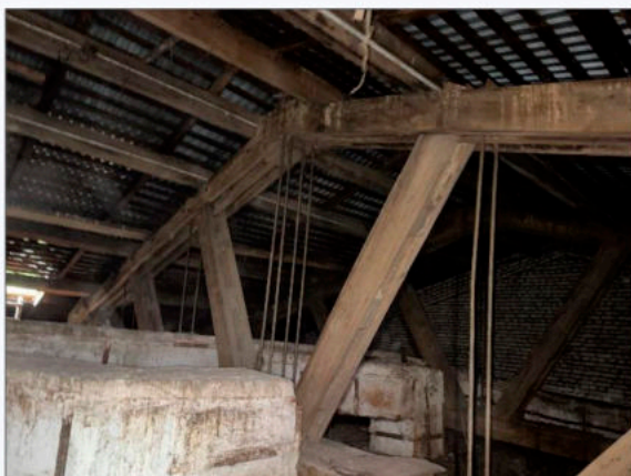
Фото 3. Общий вид стропильной системы
