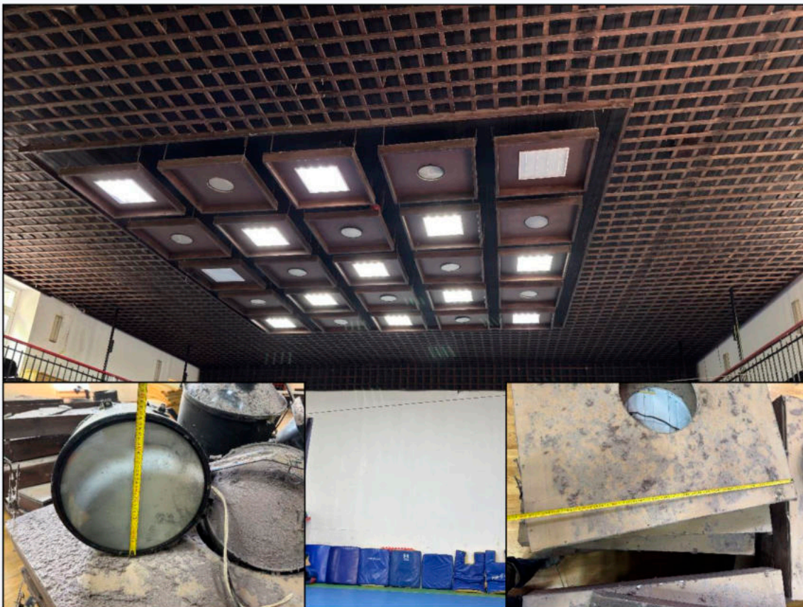
Фото 7. Общий вид деревянного перекрытия (снизу)
