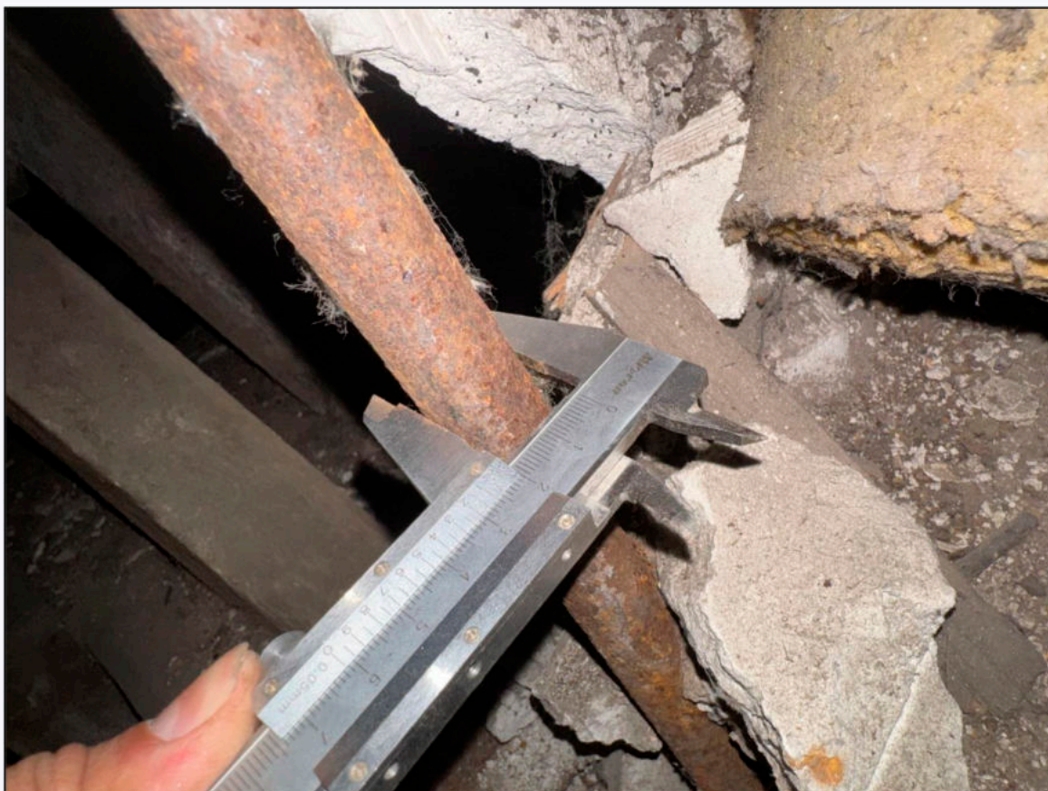
Фото 27. Определение геометрических параметров элементов стропильной системы
