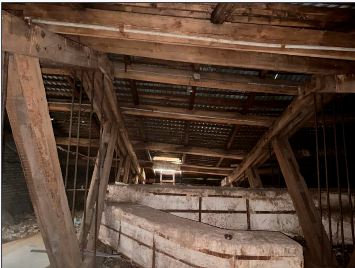
Фото 11. Общий вид чердачного помещения
