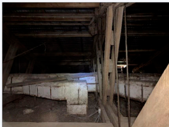
Фото 4. Общий вид стропильной системы
