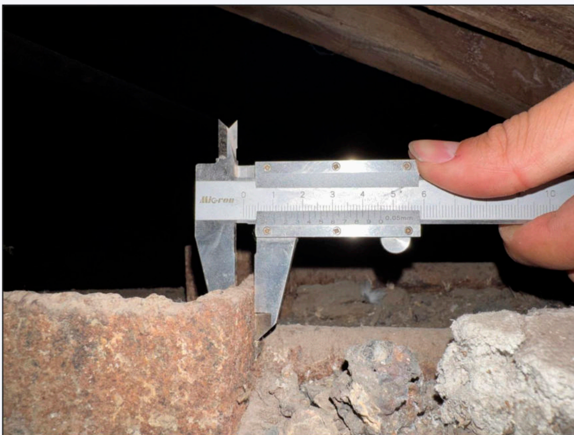
Фото 28. Определение геометрических параметров элементов стропильной системы
