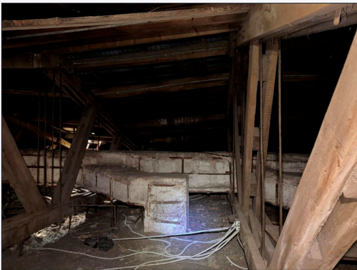
Фото 12. Общий вид чердачного помещения
