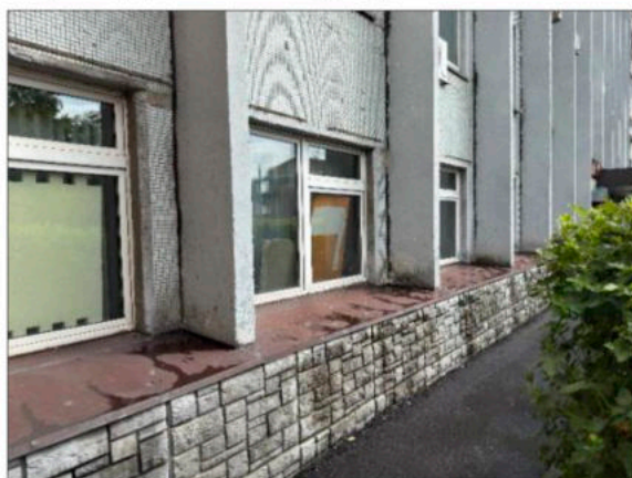
Фото 3. Локальный вид обследуемых фасадных конструкций – ламелей
