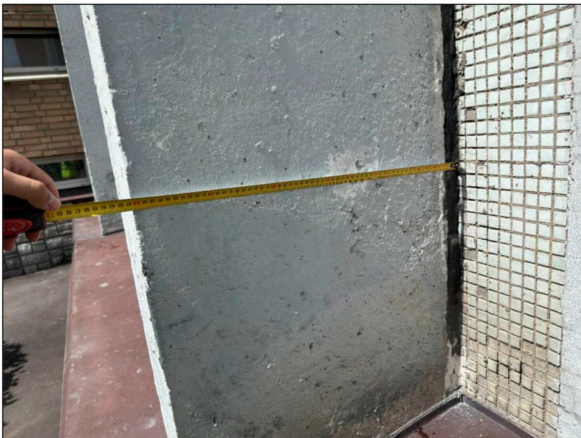
Фото 12. Определение геометрических параметров обследуемых фасадных конструкций – ламелей
