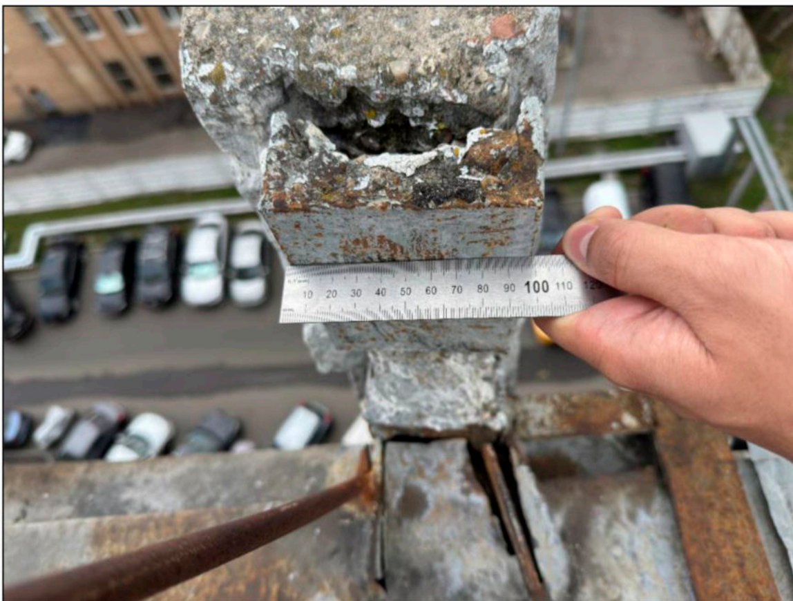
Фото 15. Определение геометрических параметров элементов обследуемых фасадных конструкций – ламелей
