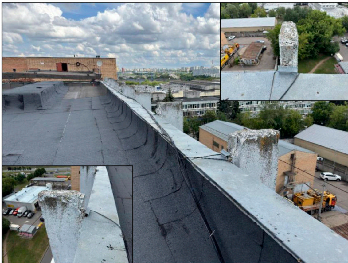
Фото 7. Локальный вид обследуемых фасадных конструкций – ламелей (с кровли)
