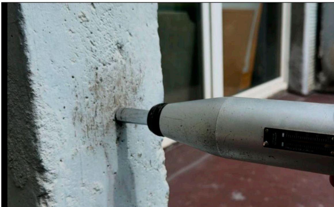
Фото 17. Определение прочности бетона прибором «Original Schmidt type N»
