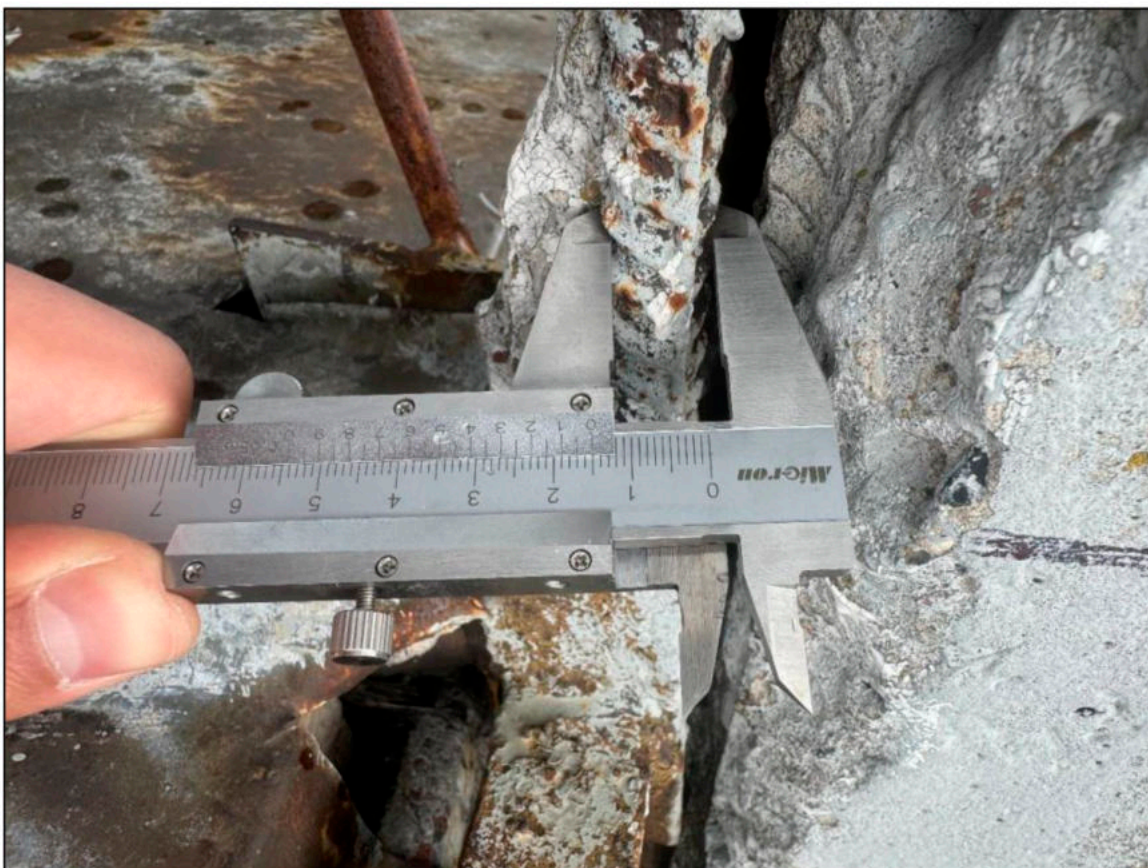
Фото 14. Определение геометрических параметров элементов обследуемых фасадных конструкций – ламелей
