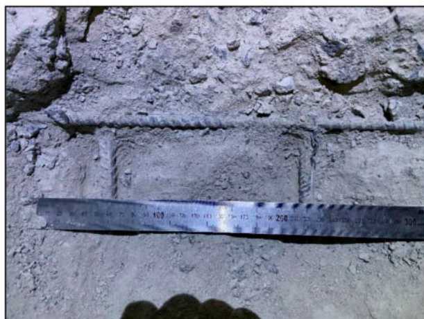
Фото 14. Общий вид измерения геометрических характеристик выполненного вскрытия.
