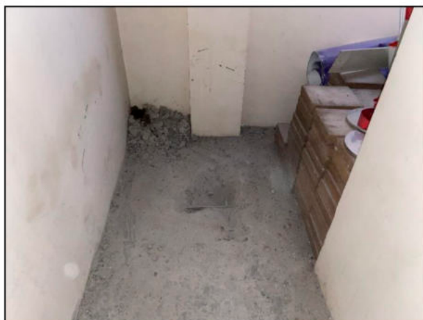
Фото 13. Общий вид вскрытия железобетонной монолитной фундаментной плиты в уровне подвала.
