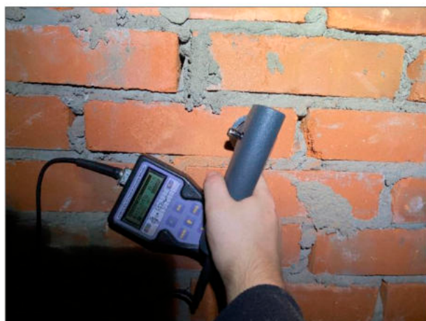
Фото 48. Общий вид измерения прочностных характеристик вертикальных конструкций надземной части здания методом ударного импульса
