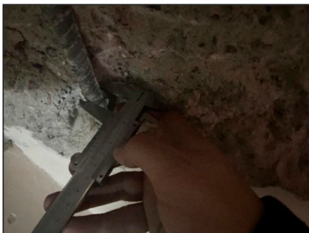
Фото 37. Измерение геометрических параметров армирования конструкции здания в осях «1-6/А-И»
