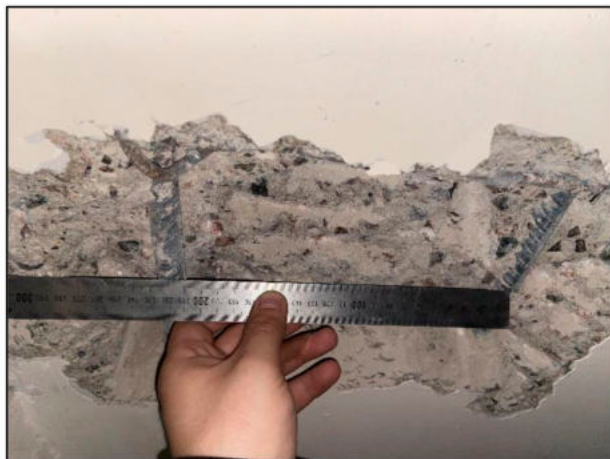
Фото 36. Общий вид вскрытия вертикальных несущих конструкции здания в осях «1-6/А-И»
