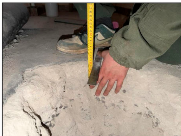
Фото 16. Общий вид измерения геометрических характеристик выполненного вскрытия.
