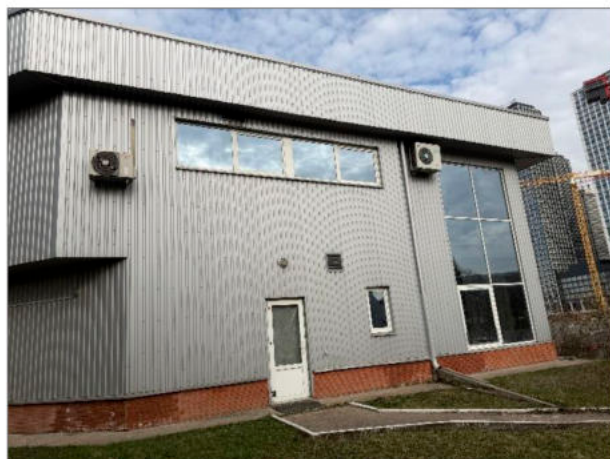
Фото 90. Общий вид конструкций входной группы в осях «1хБ-В»
