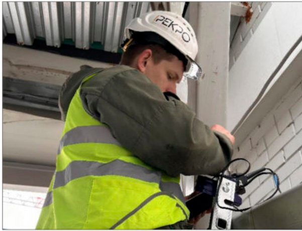
Фото 65. Общий вид измерения толщины конструкций рамы
