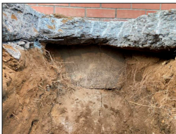
Фото 1. Общий вид конструкции фундаментов в шурфе №1.
