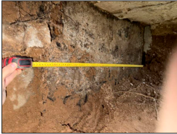
Фото 11. Измерение конструкции отмостки шурфе №3.
