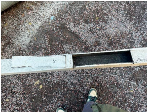
Фото 67. Отбор проб металла из конструкции рамы каркаса
