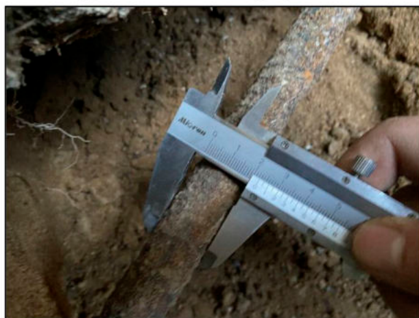
Фото 4. Измерение параметров армирования конструкции отмостки шурфе №1.
