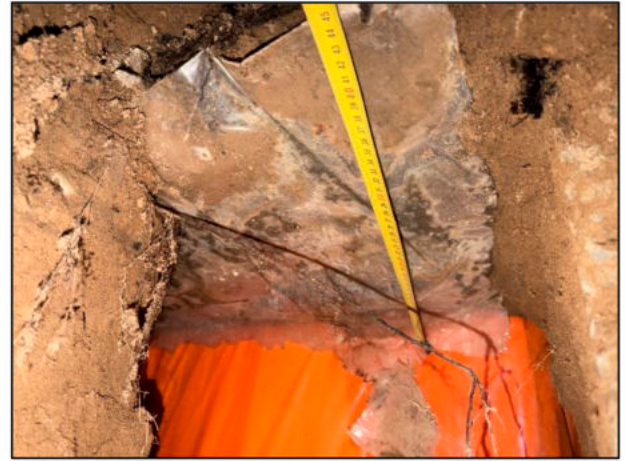
Фото 12. Измерение конструкции фундаментной балки шурфе №3.
