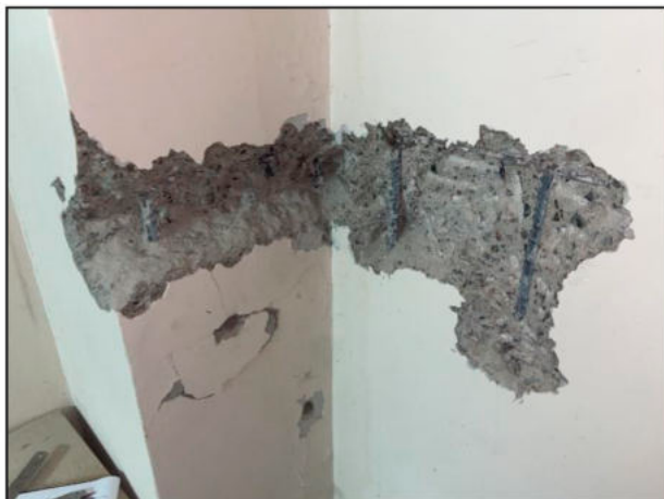
Фото 35. Общий вид вскрытия колонны и железобетонной стены в уровне подвала здания в осях «1-6/А-И»
