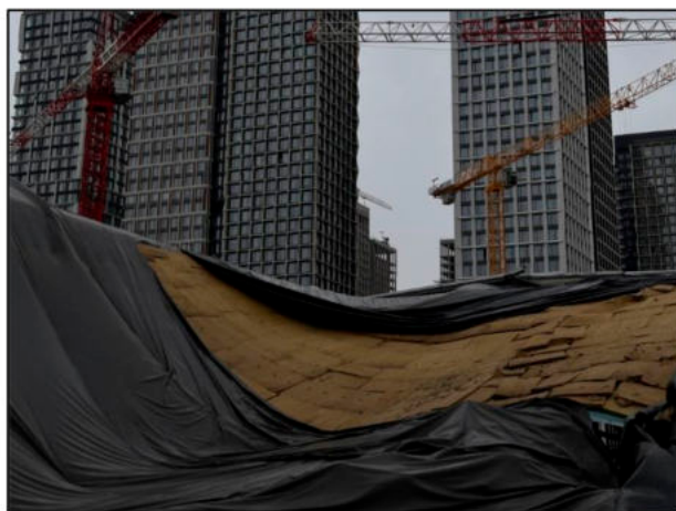
Фото 69. Общий вид кровельного покрытия здания в осях «7-18/А-И»
