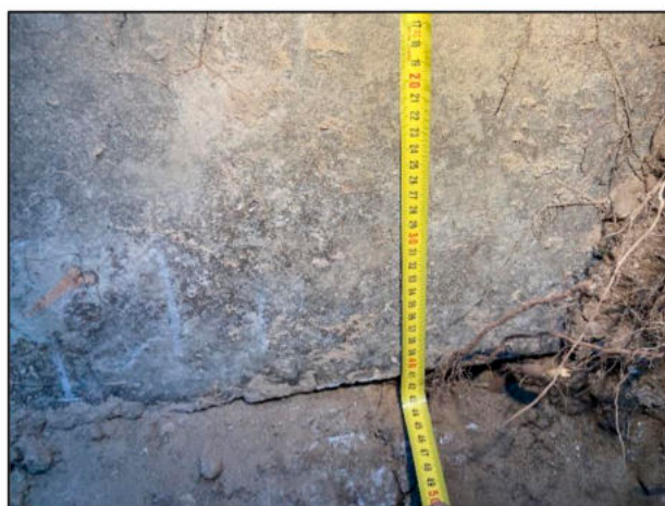
Фото 2. Измерение конструкции фундаментов в шурфе №1.
