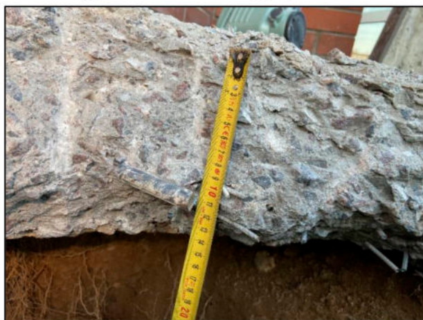
Фото 3. Измерение конструкции отмостки в шурфе №1.
